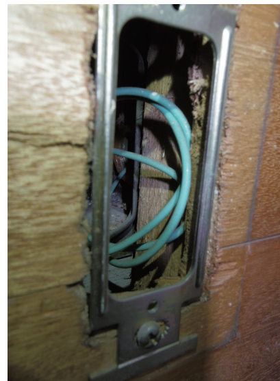
壁材質：コンセントカバーを外し、壁の断面を撮ります。
